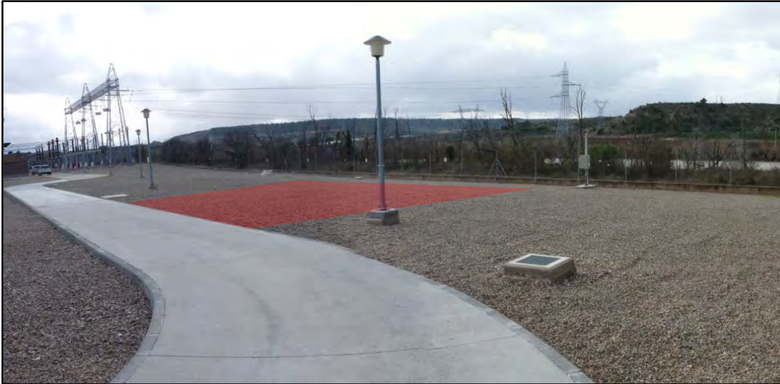
Figura 23. Posición de Els Aubals señalada en rojo. Dicha posición no se ha ejecutado, y es la parte de la ampliación que afectaba al LIC actual, que tal y como se puede comprobar se encuentra dentro de la subestación.
