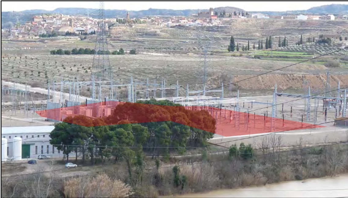
Figura 24. Se marca en rojo la zona de ocupación de la ampliación de la subestación eléctrica de Escatrón. Se puede comprobar que dicha ampliación se da en su totalidad dentro de las instalaciones de la subestación existente, sin afectarse ningún valor del medio presente.
