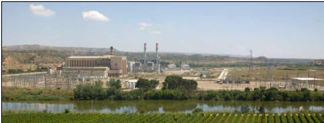
Figura 19. Vista del polígono industrial de Escatrón donde se encuentra la subestación eléctrica de Escatrón
