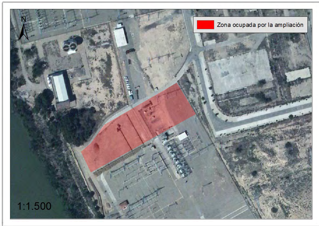
Figura 20. Superficie ocupada por la ampliación de la subestación eléctrica en proyecto.
